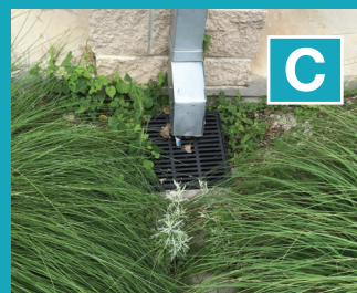
落水管通过雨水井和穿孔管导入低湿地
